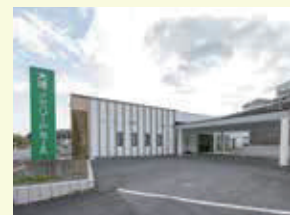
大塔メモリードホール
