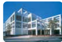
大橋メモリードホール 長崎市大橋町14-16
