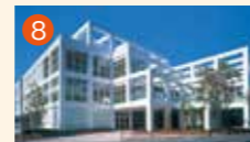
8 大橋メモリードホール 長崎市大橋町14-16
